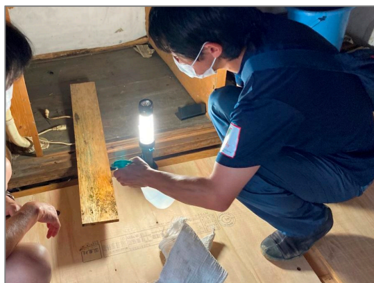
大町町の被災家屋内でのカビ除去作業 (専門技術系支援組織「風組関東」による支援)
