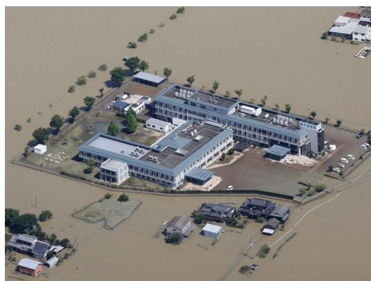
令和 3 年 8 月豪雨 順天堂病院周辺の浸水の様子
